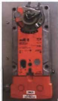
Belimo Actuator for Louvers EFB120-S N4 Model 240 Volt Typ of 4
